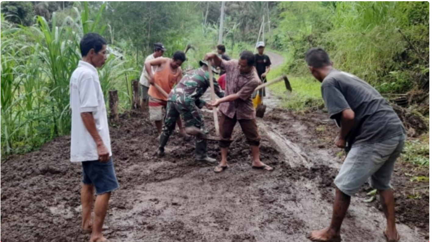
Babinsa Koramil 1609-06 /Banjar gotong royong bersihkan longsoran tanah yang menutupi jalan
